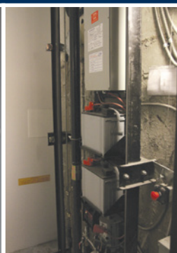
Mécanique 24V à l'intérieur de la cage d'ascenseur
