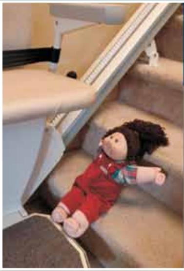
Pour assurer la sécurité, le repose-pied est doté de rebords avec capteurs sur toutes les surfaces supérieures, inférieures et latérales
